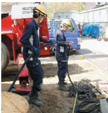
高圧ケーブルの延線
