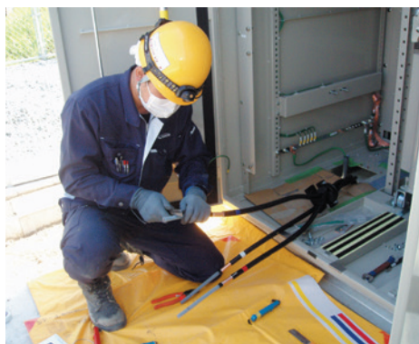
高圧ケーブルの端末処理
