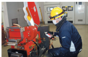
遮断器の点検・清掃
