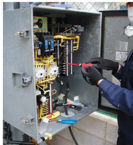
ケーブル芯線の接続
