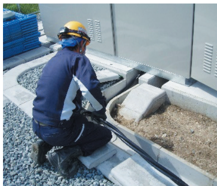
高圧ケーブルの敷設
