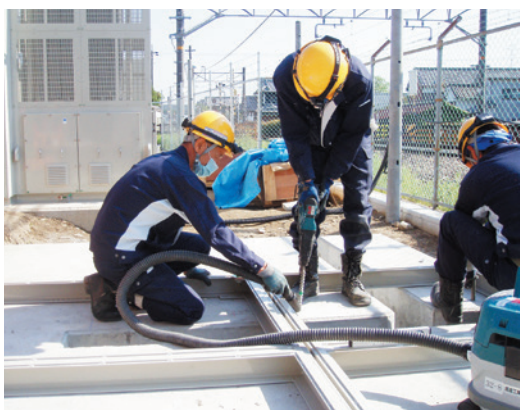
重量物を固定するためのアンカー打設
