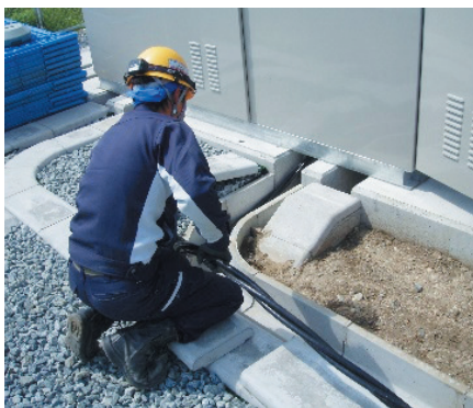
高圧ケーブルの敷設
