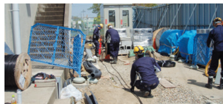
低圧ケーブルの敷設
